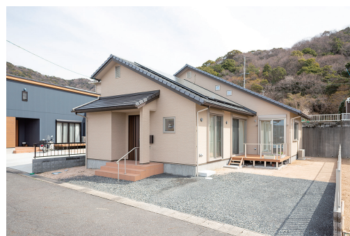
切妻屋根を2つ並べた形が目を引く外観。一見すると平屋建てに見えるが、2階建て
