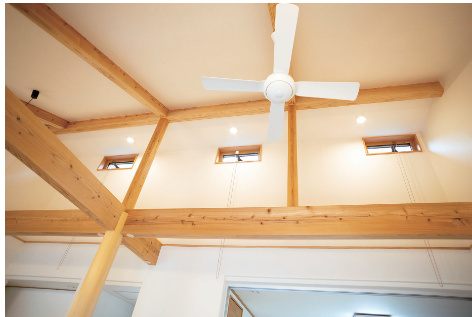
リビングの天井近くに開口した3つの窓。夏は熱い空気を排出するとともに、明るさを取り込む役割を果たしている
