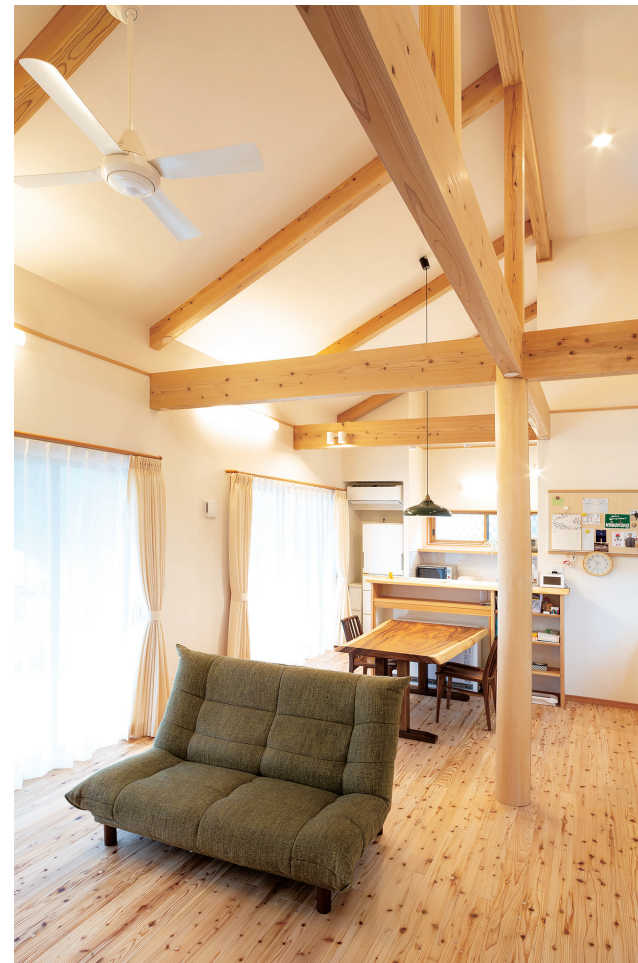
床にあしらったスギの無垢材はうづくり仕上げのため足触りが心地良い。開放感と外の緑を楽しみたいため、リビングの窓はできるだけ大きく開口するようご主人が要望した
