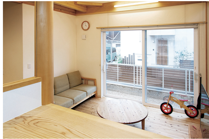
キッチンから庭を望む広い窓は断熱・防音仕様の樹脂ペアガラス
