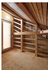
2階に設けた小屋裏にはほとんど使うことのないものを入れておく予定。居住性は考慮せず、済むため、予算配分を考えて壁や床、天井などには内装を施していない
